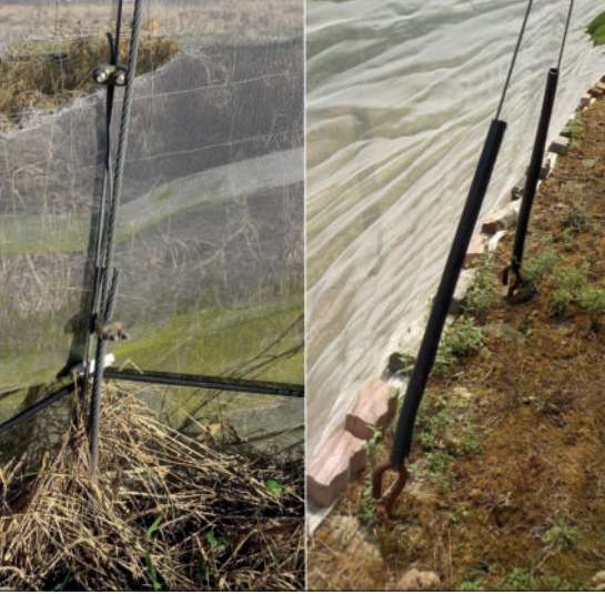
Abb. 7: Netzbeschädigungen durch Reibung mit der Abspannung des Foliendachs, rechts: Schutzrohr gegen Netzbeschädigungen
